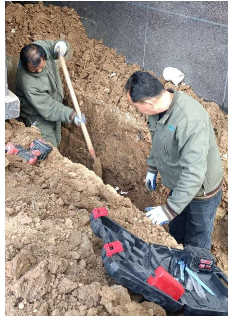
经过四天时间的奋战，终于完成了三处管道维修和回填，成功解决了小区9栋、11栋、25栋主管道经常堵塞的问题，实实在在解决了业主的烦恼，维修完工后，保洁也第一时间为业主将地面清理干净，恢复原貌，还业主一个干净整洁的家。
